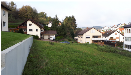
Stützwand zwischen Am Hüttenberg 1 und 3
