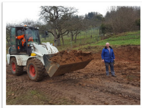
Aushub für die Lagerhalle am Bauhof durch unsere Bauhofmitarbeiter
