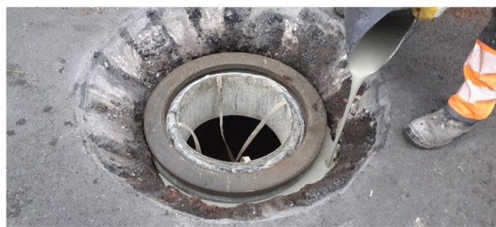
Kontrollschachtsanierung
