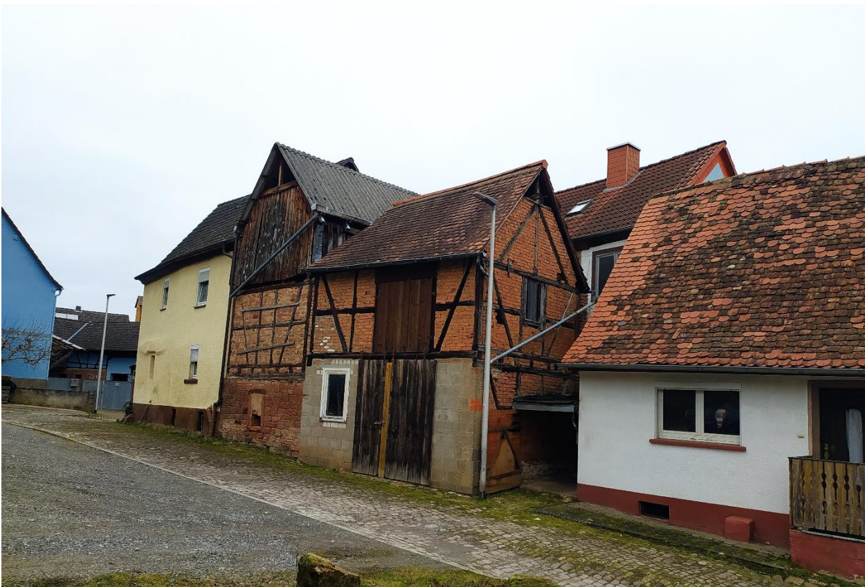
Abb.2: Blick auf die westliche Seite der betroffenen Gebäudeinsel, vom Parkplatz aus
