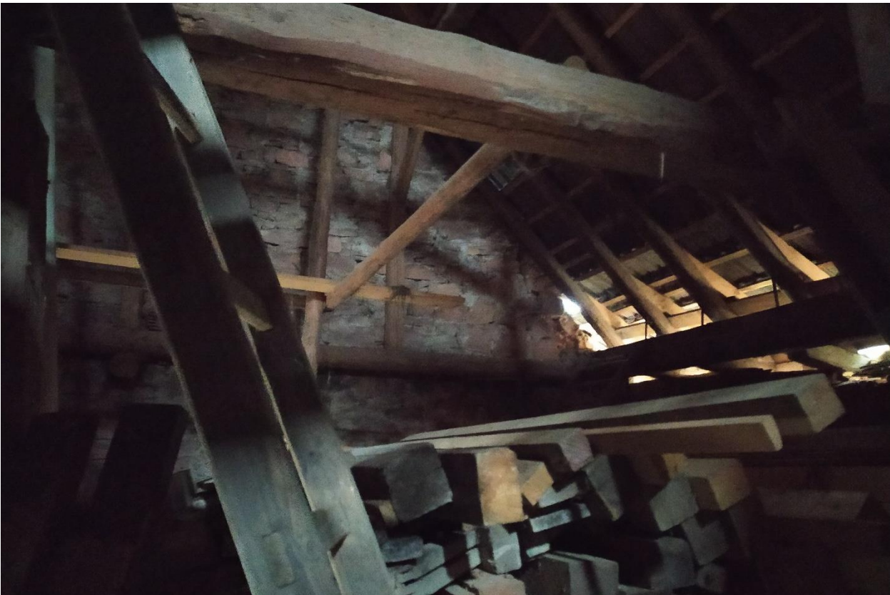
Abb.15: Innenbereich der nordöstlichen Scheune mit Habitatpotential
