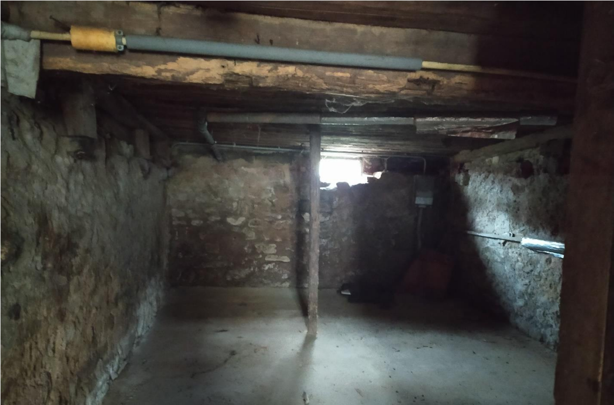
Abb.5 offener Kellerbereich samt Spalten und Nischen
