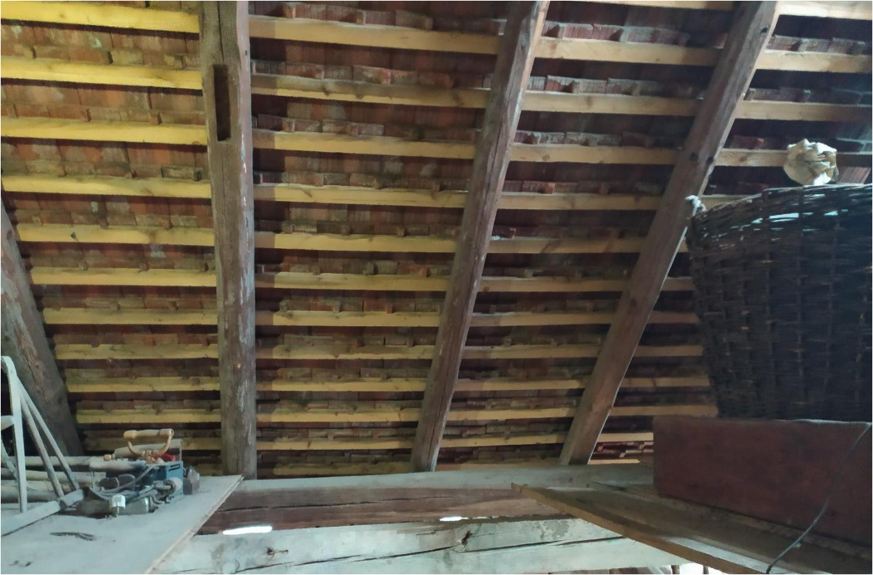
Abb.11: Dachboden mit Habitatpotential
