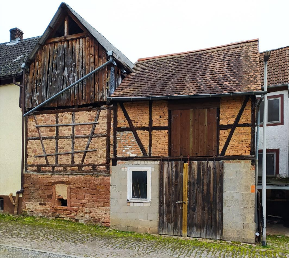
Abb.12: Schuppengebäude in der Mitte der Gebäudeinsel
