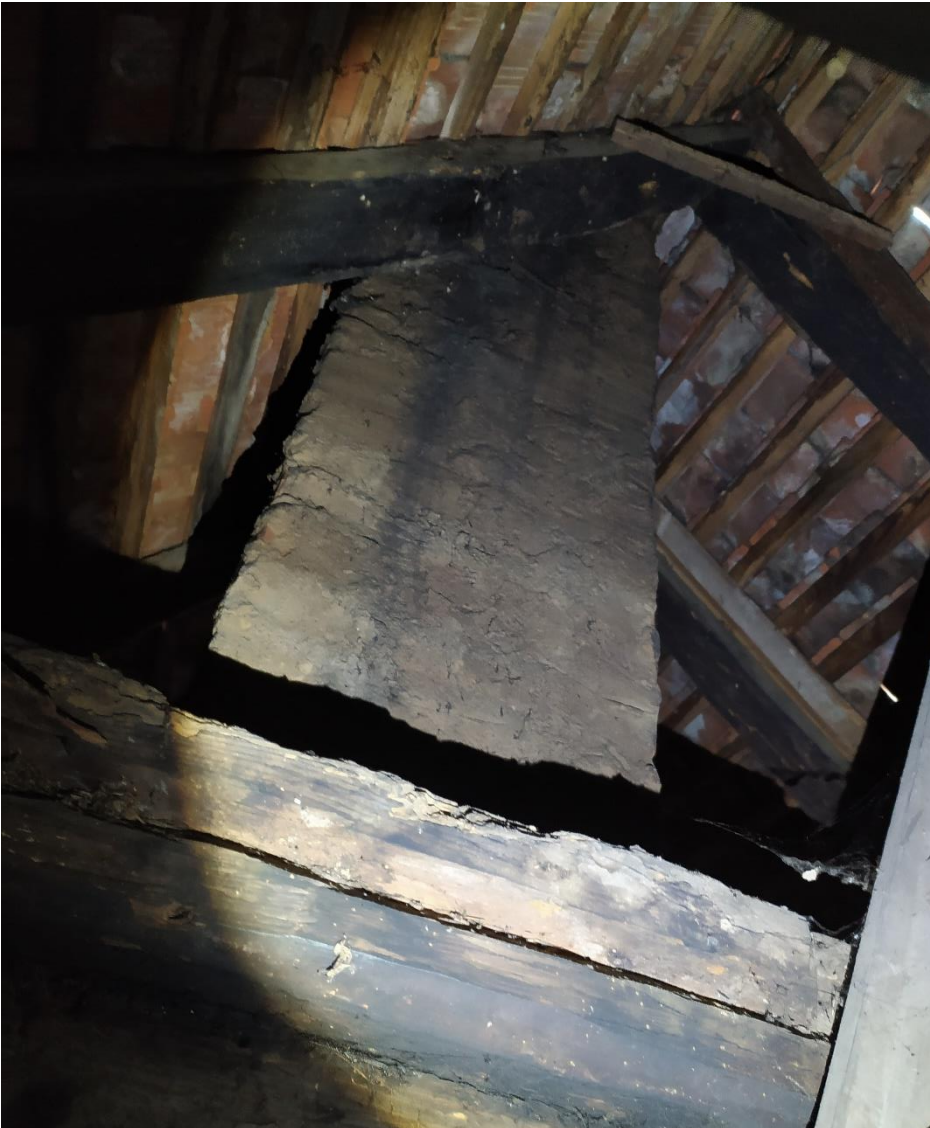
Abb.4: geschlossener Dachboden ohne direkten Hinweis auf entsprechende Nutzung
