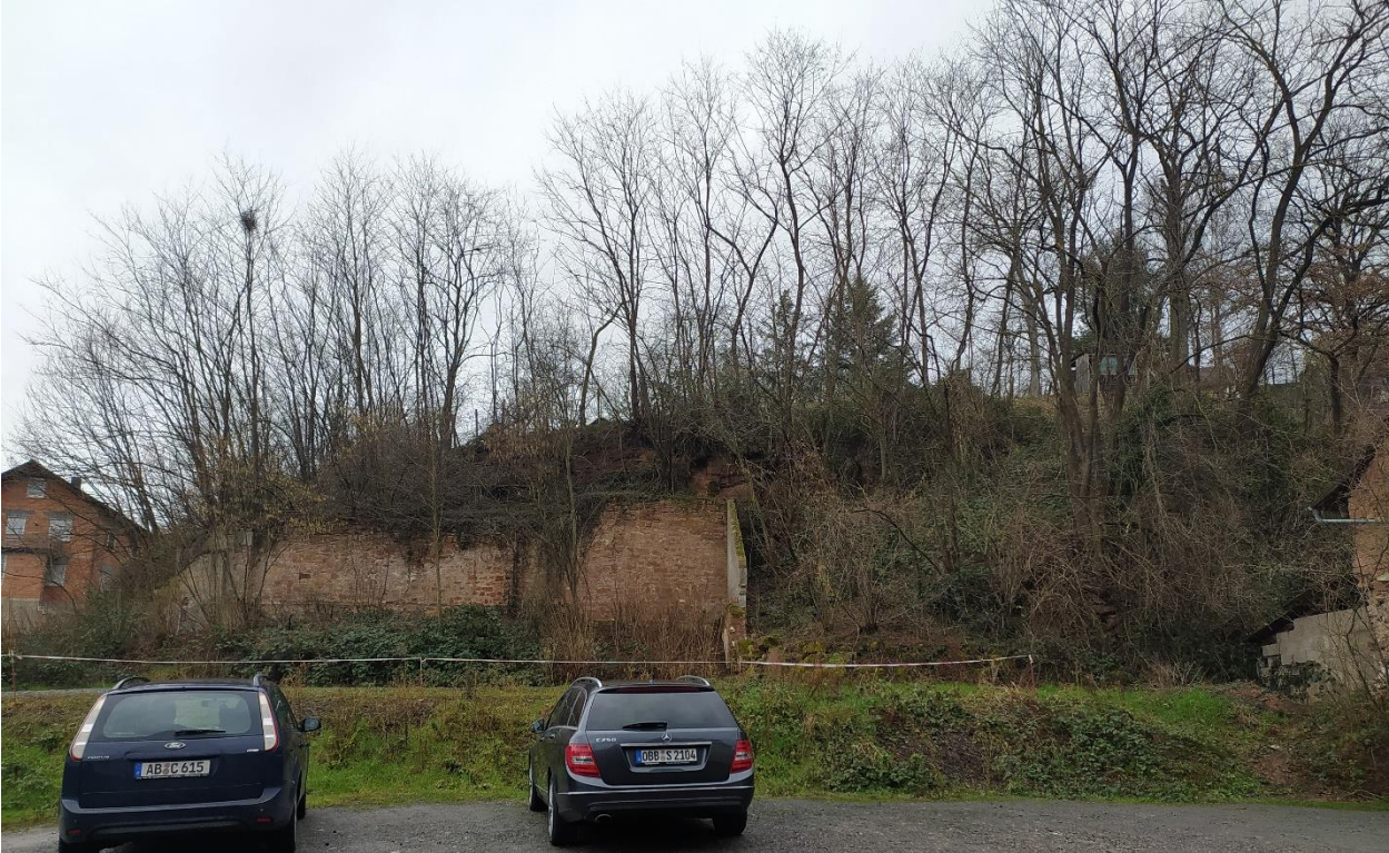
Abb.16: Blick von den Gebäuden auf das Planungsgebiet, einschließlich des gehölzbestandenen Hanges
